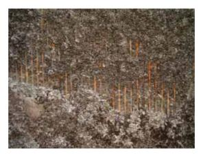
図 1-20. スクリーンの状況(上側は以前に棒で掻き落とした部分。上側には新たに付着した比較的小型の個体が見られる。)
