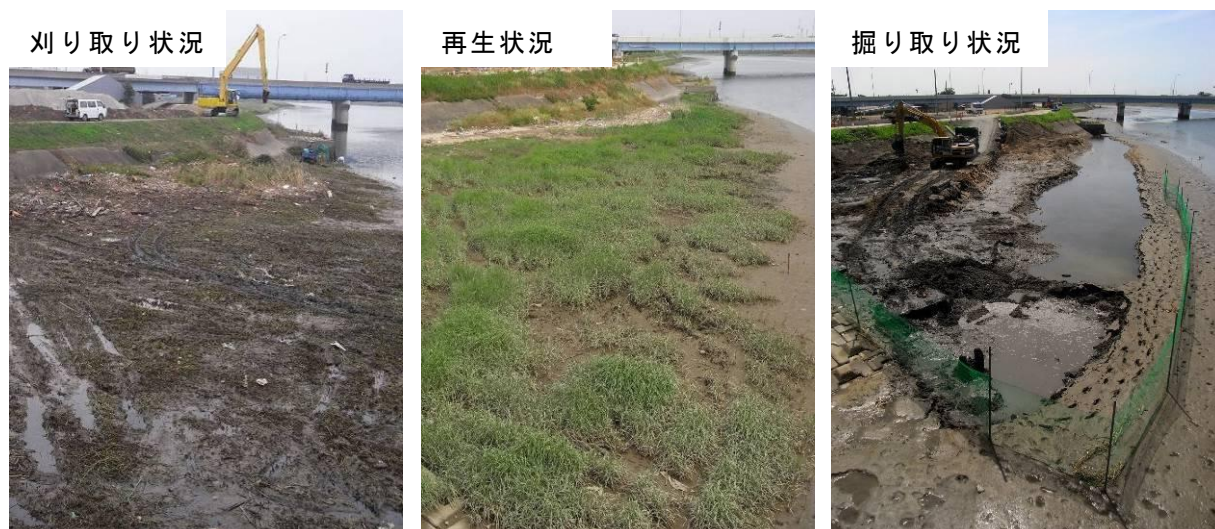
図 29 スパルティナ・アルテルニフロラの刈り取り状況（2011.10.13）、刈り取り後の再生状況（2012.6.4）掘り取り状況（2012.7.18）（梅田川右岸の大崎橋より上流）
