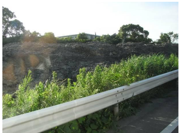
図44 県道2号(豊橋渥美線)の中央分離帯に積まれた掘削土(2012.7.18)
