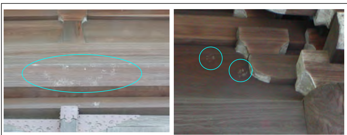
図 3-19 お寺の外壁に付けられた足跡
