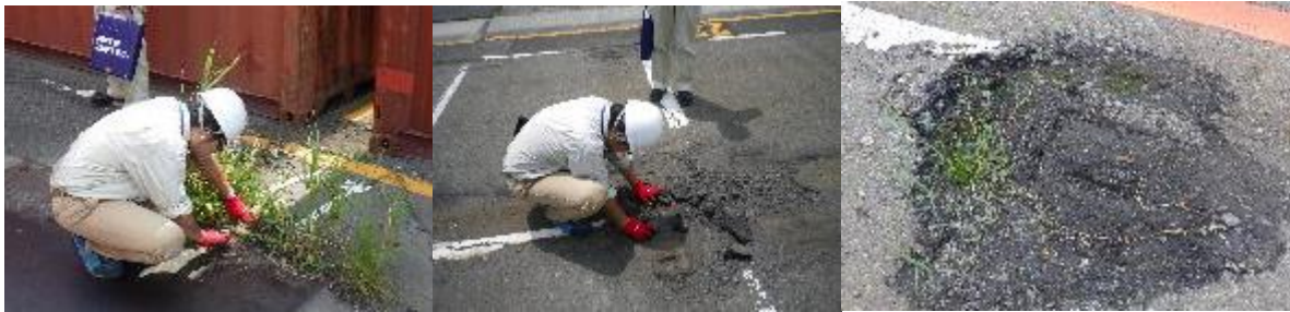
コンテナヤードでの確認
