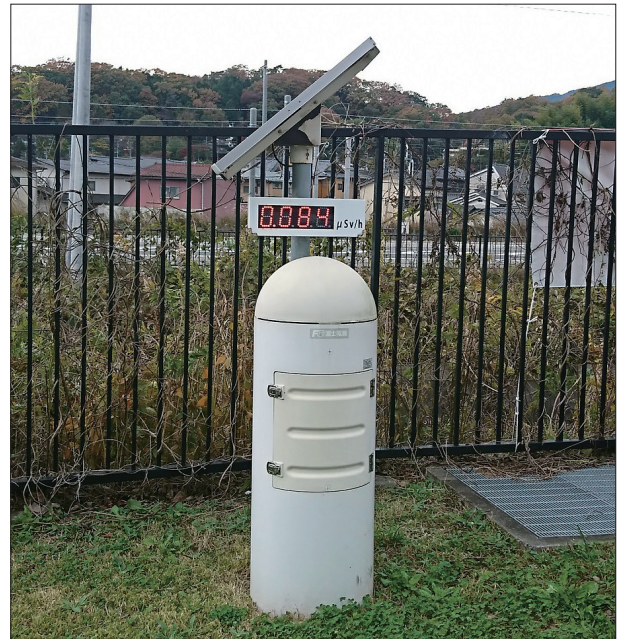
實際測量儀器（監測點）的情景
