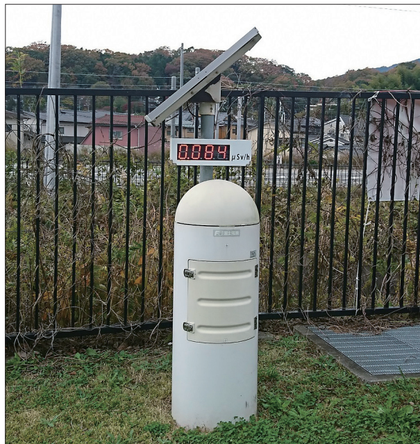
實際測量儀器（監測點）的情景
