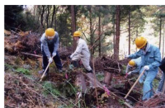
<水源の森づくり 作業状況>
