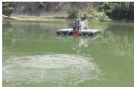
MSJ-150 縦型の設置運転状況
