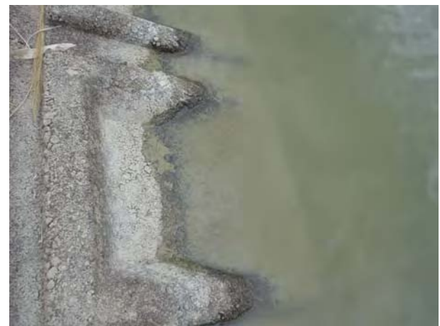
図 4 - 3 池岸の状況 (写真) (巻上げられた底泥がブロックに付着している)
