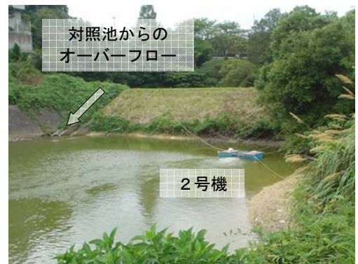
実証対象機器の設置状況
