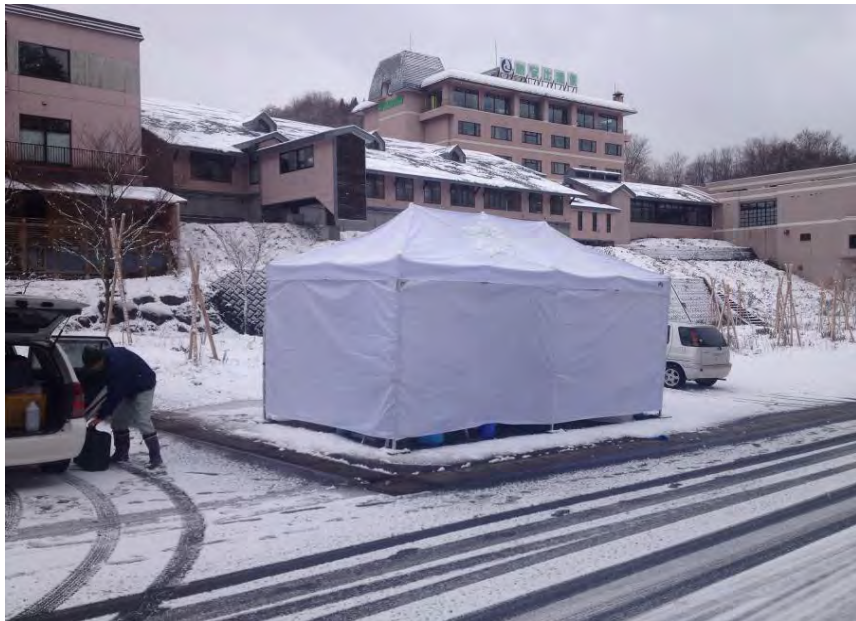
写真 2-3 機材設置場所養生（プラントはテント内に設置）
