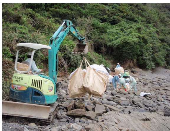
重機による搬出(第1回調査)
