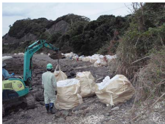
重機による回収・搬出(第1回調査)
