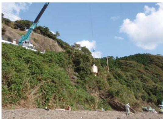
16t クレーンによる回収(第1回調査)
