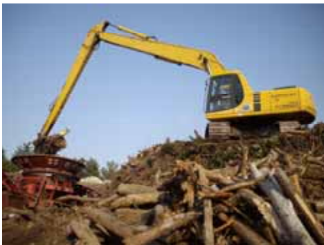
図 2.3-1 破碎処理プラント
