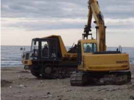
バックホウによる回収（平成 20 年 4 月）
