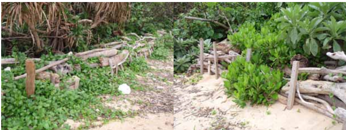
図 2.1-5 西表島で実施した流木の流出防止措置（杭による固定）
