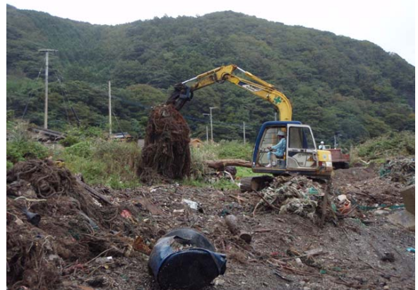
重機による回収（第1回調査）
