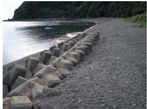
第 1 回 独自調査後(2007/10/16。人力+重機)
