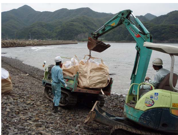
重機による不整地車両への積み込み （第1回調査）
