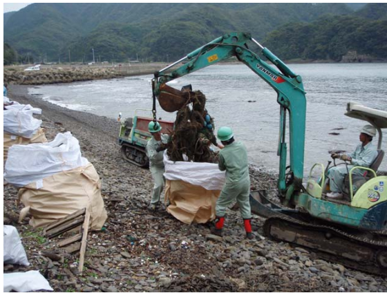
重機による回収（第1回調査）
