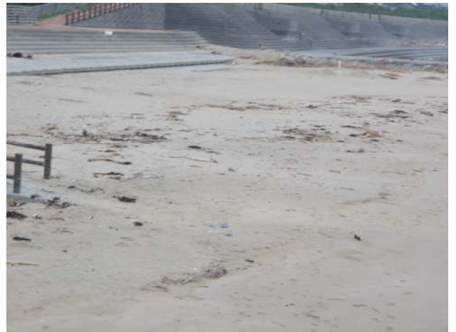
撮影方向②の海岸の状況（ズーム）
