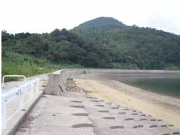
撮影方向②の海岸の状況（広角）
