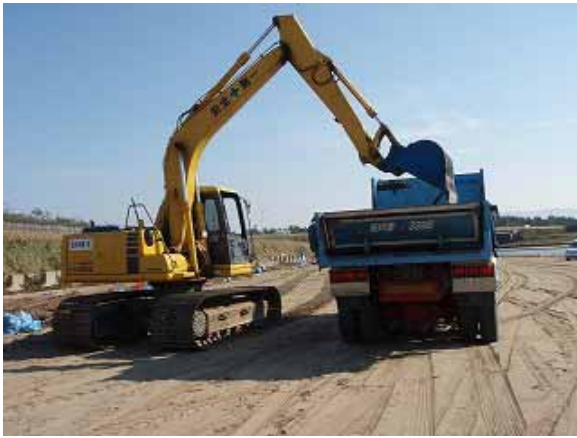
第1回調査 バックホウ、10tトラック
