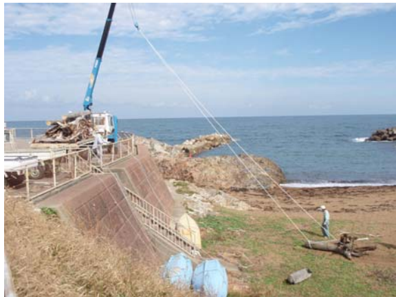
クレーン付き車両による流木の搬出(梶地区)
