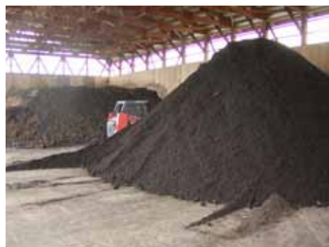
堆肥化施設状況
