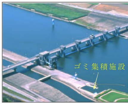
筑後大堰とゴミ集積施設 「出展: 屋宮・関根、ゴミ集積施設の設計とその効果、国土交通省九州地方整備局ホームページ( http://www.qsr.mlit.go.jp/n-event/kenkyu/pdf/ii-21.pdf )」
