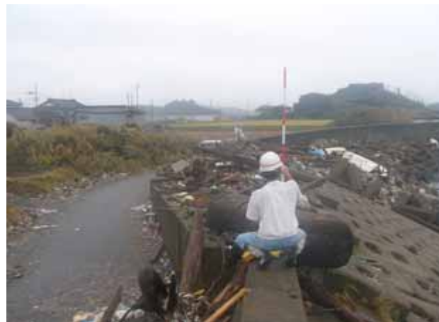
流木と一緒に漂着したゴミの堆積により、消波機能が損なわれた消波工(秋田県:平沢漁港海岸)
