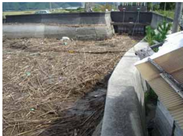
流木と一緒に漂着したゴミの堆積により、樋門の開閉機能が阻害(熊本県:一町田海岸)
