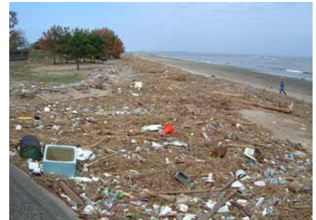
流木と一緒に漂着したゴミ(ドラム缶、浴槽など)による損傷の恐れ(三重県:津松坂港海岸)
