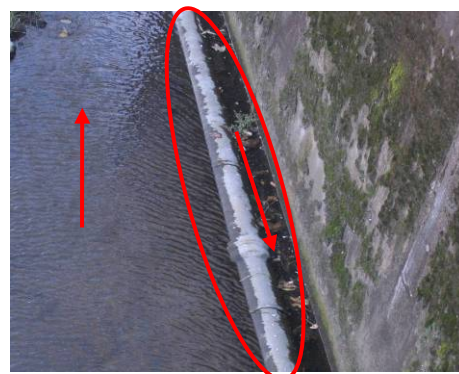
河川内に設置した送水管
