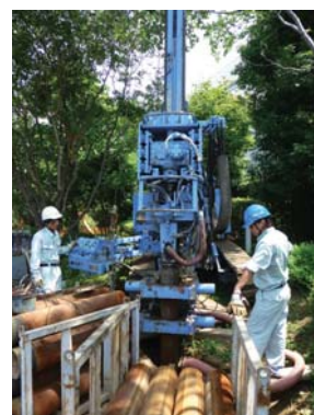
ボアホール掘削作業
