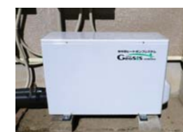
地中熱ヒートポンプ
