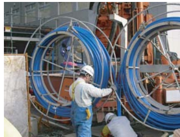
Uチューブ挿入作業 (ダブルUチューブ)
