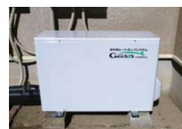
地中熱ヒートポンプ
