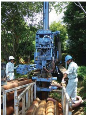
ポアホール掘削作業
