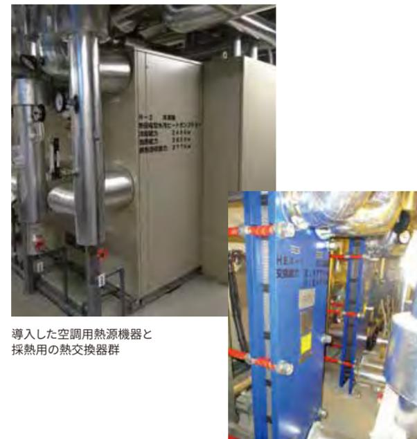
導入した空調用熱源機器と採熱用の熱交換器群
