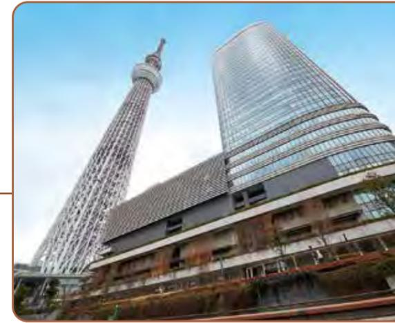
東京スカイツリー地域では、日本の地域冷暖房では初めて地中熱利用システムを採用しました。基礎杭とボアホールに設置されたチューブを使って地中熱と熱交換します。その熱を利用して夏は冷水、冬は温水を作って地域の冷暖房の一部として利用します。
