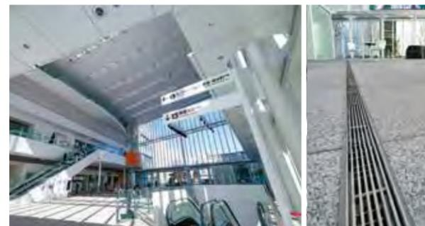
アトリウムにある地中熱を熱源とする床吹出空調。その他床輻射冷暖房にも活用し、床の下には冷温水が流れる管が埋まっている。3月でも床を触るとほんのり温かい
