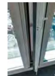
自然換気専用のパネルで、超高層の建物にも関わらず外の風を感じることができる
