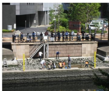
写真：国土技術総合研究所、 東京都、港区 生物生息に配慮した テラス型護岸（芝浦運河）
