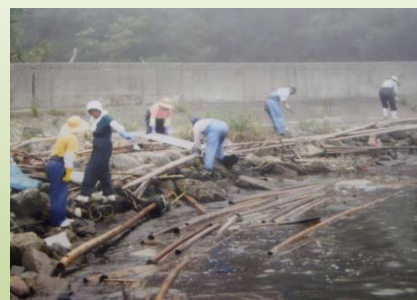
松島湾寒風沢島におけるがれき撤去。主に人力で行われた。(2011年10月；提供：宮城県漁業協同組合 塩竈市浦戸東部支所)
