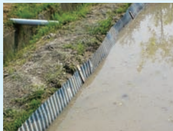
畦波板の設置
