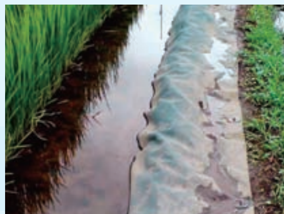
畦畔被覆シートの設置
