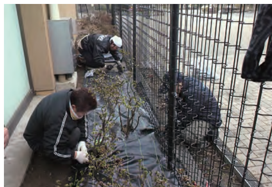
防草シート設置作業
