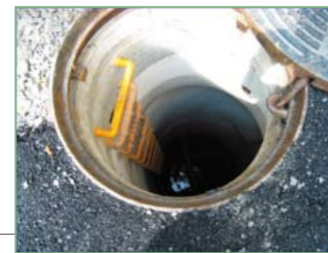
井戸等の地下水 (環境基準0.01mg/lで判断)
