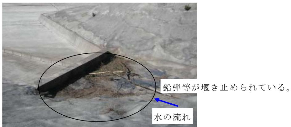
図5-31 鉛弾等を吹付け法面の途中で堰き止める構造の例
