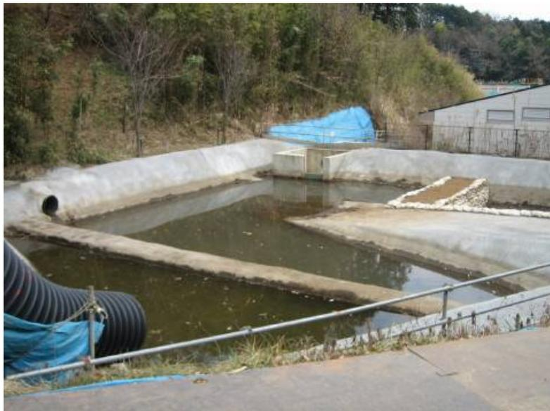
図5-19 沈殿池の例
