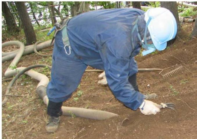
エア圧力を利用した鉛弾混じり土壌の回収の例
