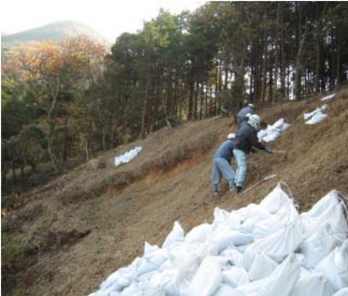
植生を伐採して鉛弾を回収している状況 (ここでは、急斜面で重機等が入れないため、伐採、回収作業は人力で実施している。)
