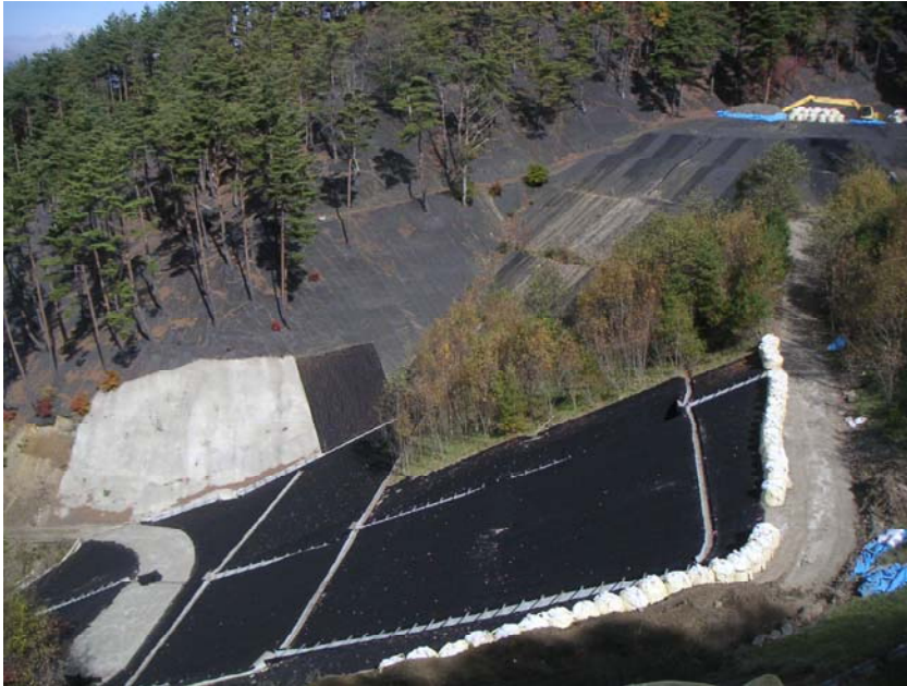
【対策例】 透水性シート（不織布） の敷設状況
