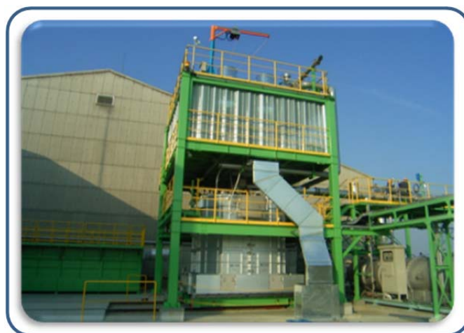
図 1.5.1-3 浄化等処理施設（溶融）の例
