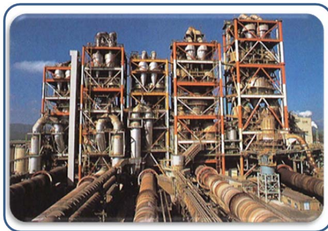
図 1.5.1-4 セメント製造施設の例
