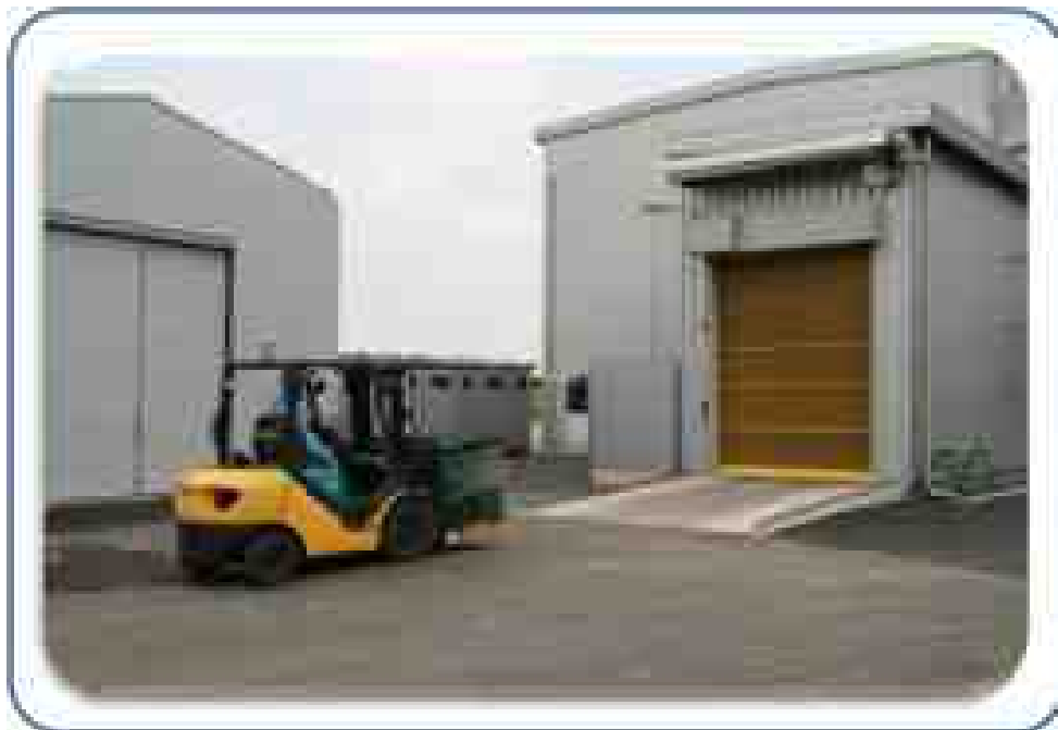
図 2.2.6-2 飛散防止措置が講じられた施設内移動の例
