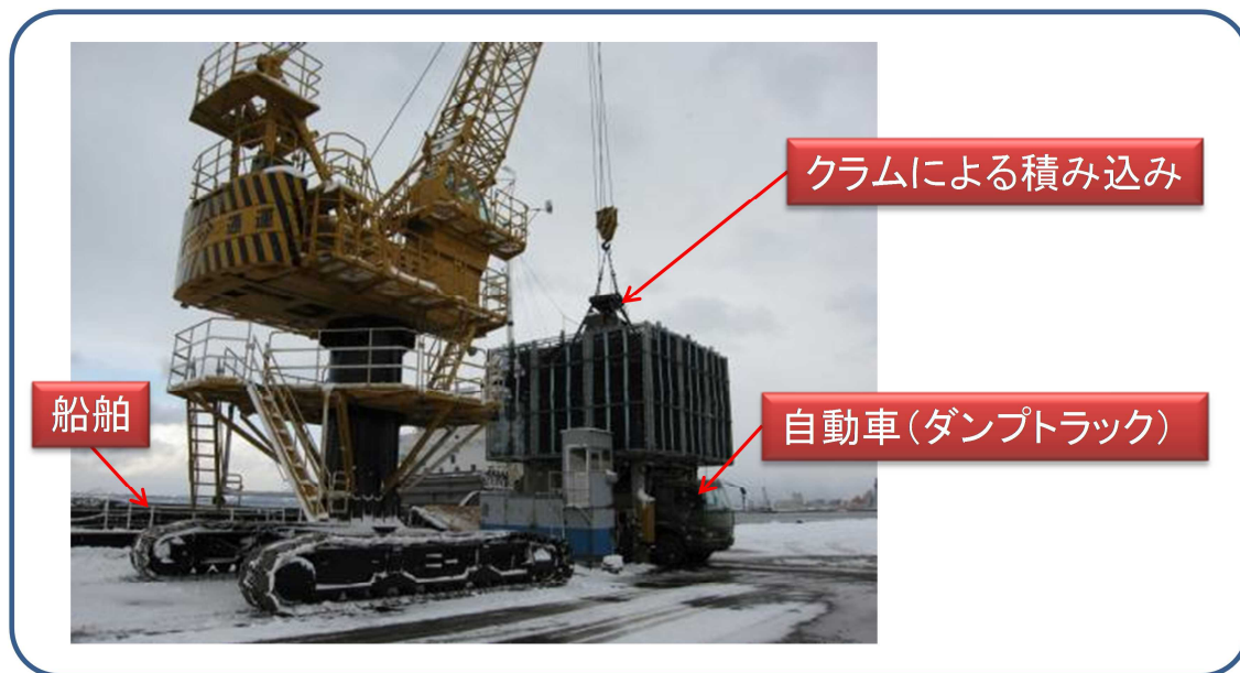
図 3.6.6-1 埠頭における積替え作業の例
