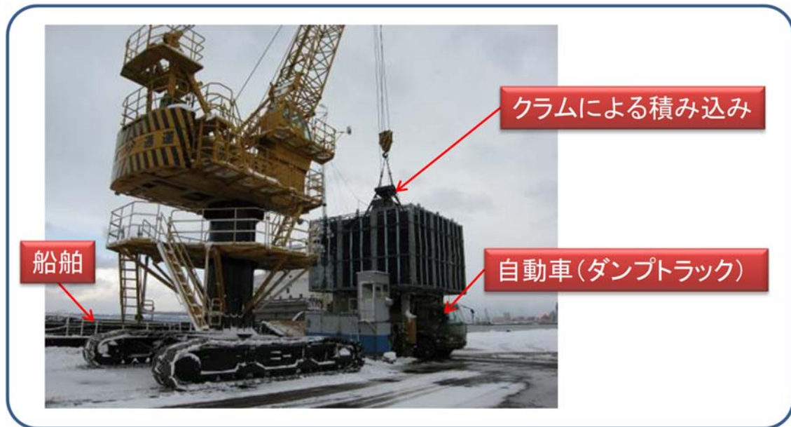
図 3.6.6-1 埠頭における積替え作業の例
