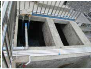
生物ろ過槽・沈殿槽
