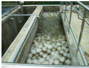
接触曝気槽
