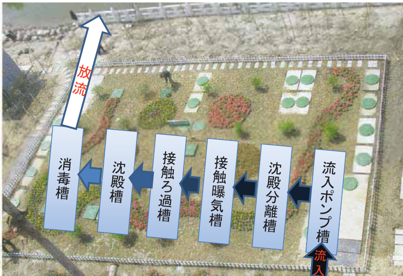
処理施設プロセスの概要(上空からの写真)
