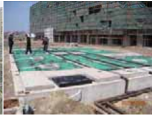
施設の建設状況(覆土前)
