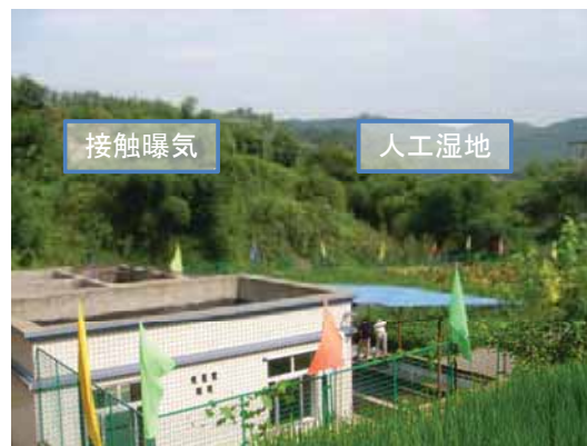
処理施設の全景
