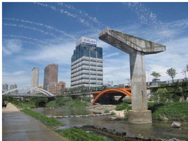
かつての橋脚をそのまま保存
