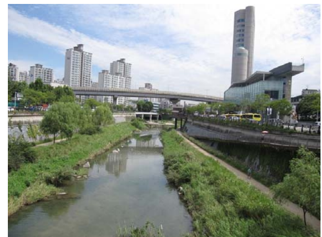
清溪川ミュージアム付近（写真右）
