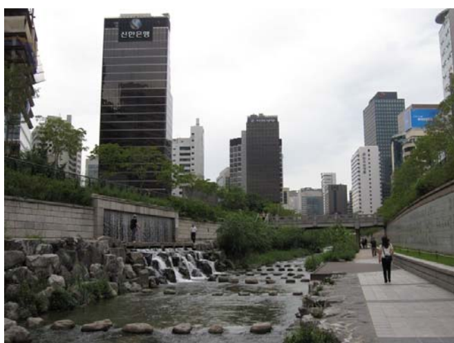
滝で覆う排水幹線合流部（写真左側）
