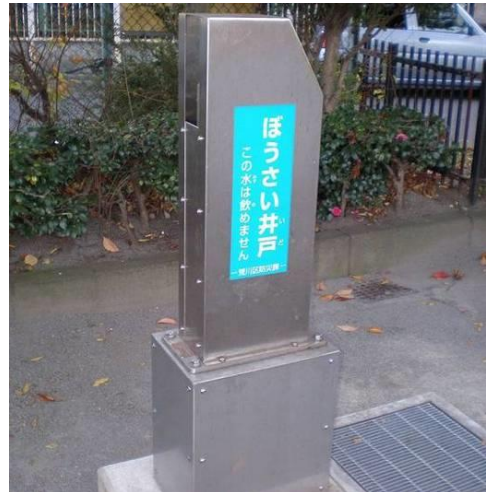
写真 1 防災井戸の例（荒川区）
