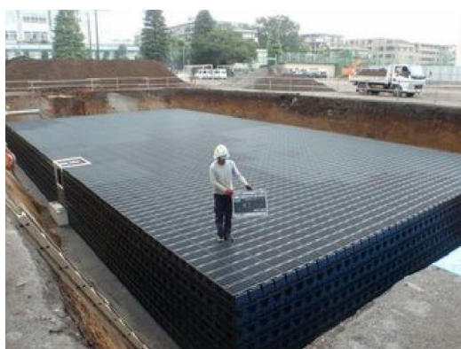
写真3 雨水貯留浸透施設（武蔵野市） 4)
