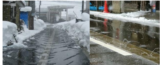
写真1 散水消雪施設
