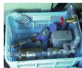
地下水循環ポンプ (インバータ制御)
