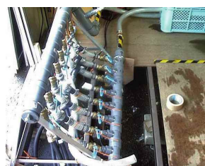
地下水循環制御装置 (マンifold)
