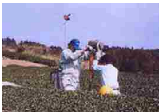
図 4-2-12 ボーリング調査
