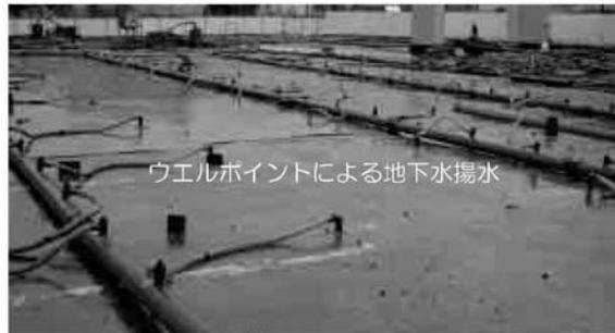
図 8-142 地下水揚水の概況写真
