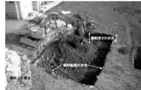
図 4-134 掘削除去の概況写真
