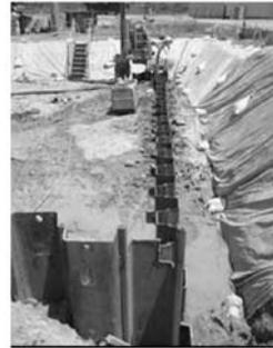
図 8-192 遮水壁（鋼矢板）の打設状況
