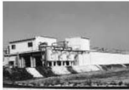
▲排水処理施設
