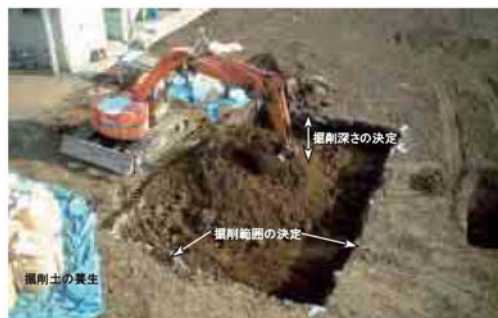
図 4-13 掘削除去の概況写真
