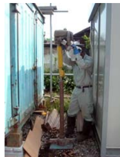
簡易ボーリング機械（SCSC） を用いた観測井設置状況
