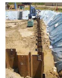
図 4-19 遮水壁（鋼矢板）の打設状況
