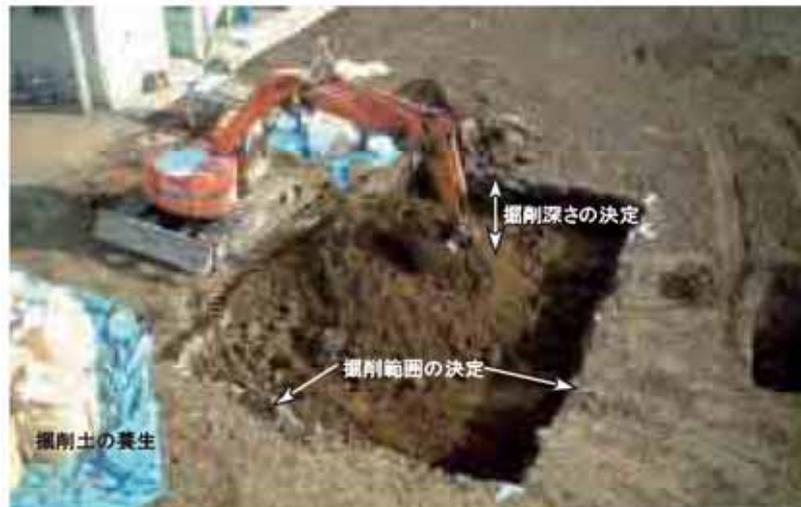
図 5-13 掘削除去の概況写真
