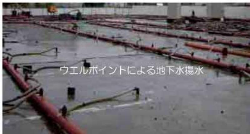
図 5-11 地下水揚水の概況写真
