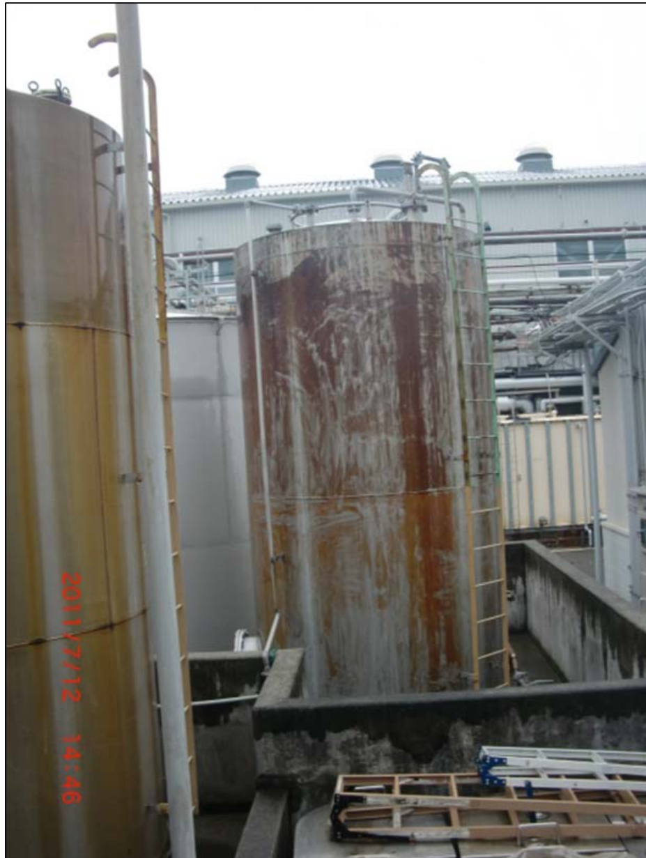
タンク裏側から撮影
