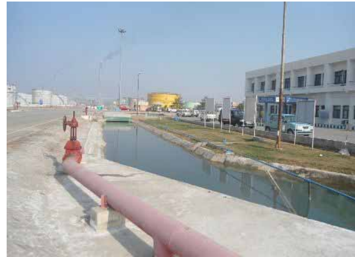
プラント内側溝は排水で一杯の状態
