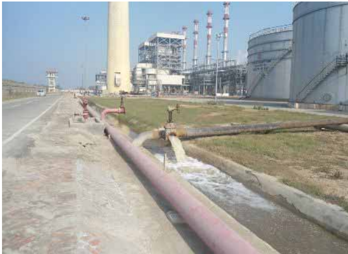
プラント内処理水排出口
