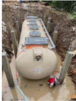
本体据え付け
