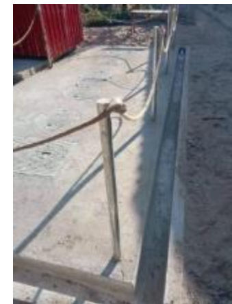
排水溝（雨水対策）
