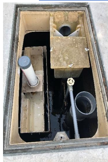
沈殿槽・消毒槽
