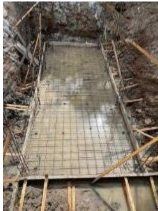
底盤スラブ配筋
